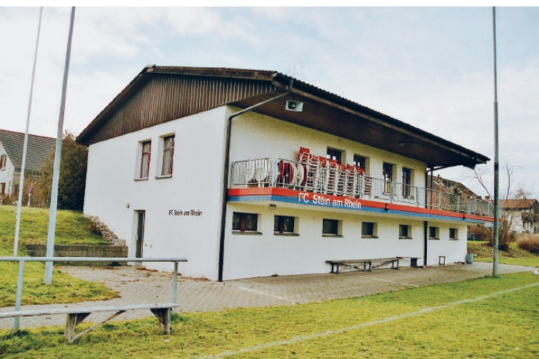
Das Clubhaus wie man es heute kennt. Der Kredit für den Bau wurde 1984 gesprochen.
